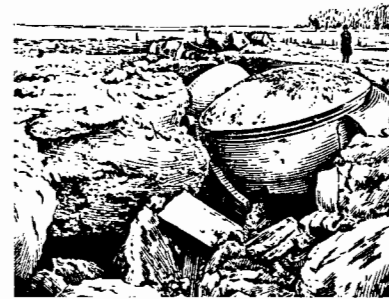
Бетонные сооружения одного из фортов Льежа, разрушенные снарядами германской тяжелой артиллерии
