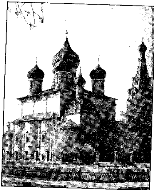
Церковь Ильи Пророка в Ярославле
